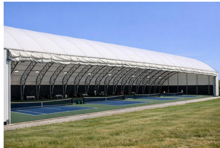
Hala łukowa z całym bokiem przejściowo zwiniętym – otwarta z jednej strony
