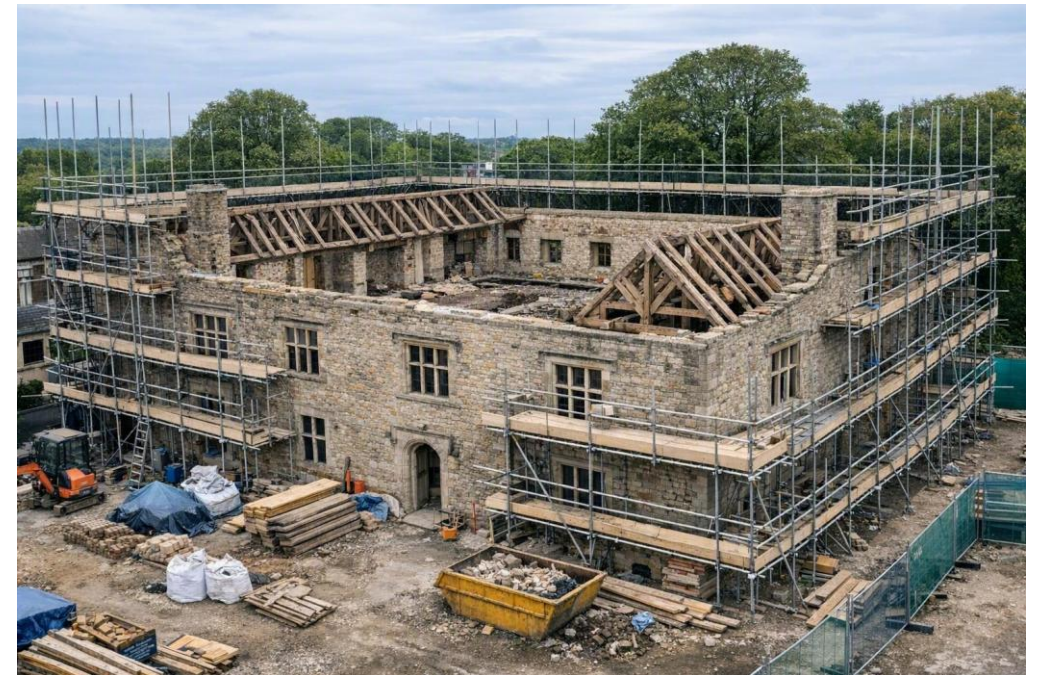
Remont budynku z przejściowym demontażem dachu do wymiany
