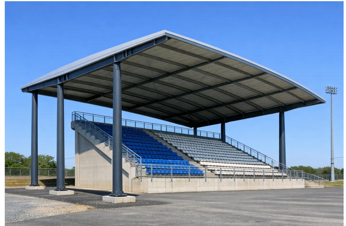
Zadaszenie jako odrębny obiekt konstrukcyjny względem trybuny
