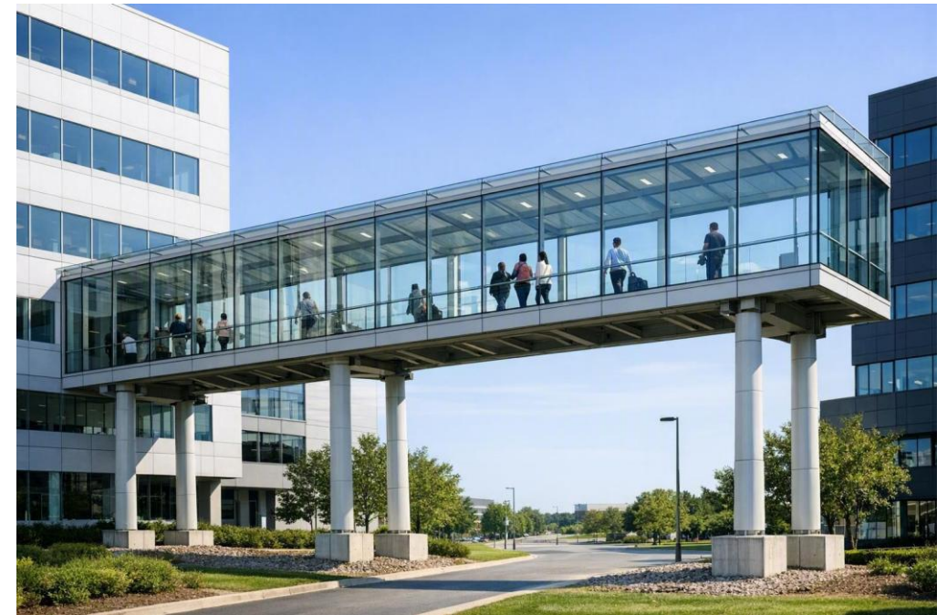
Obudowana kładka dla pieszych oparta na dwóch pylonach z fundamentami
